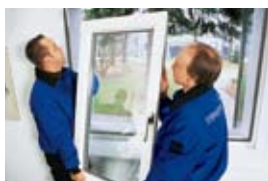
Montage – saubere Arbeit zum vereinbarten Termin
